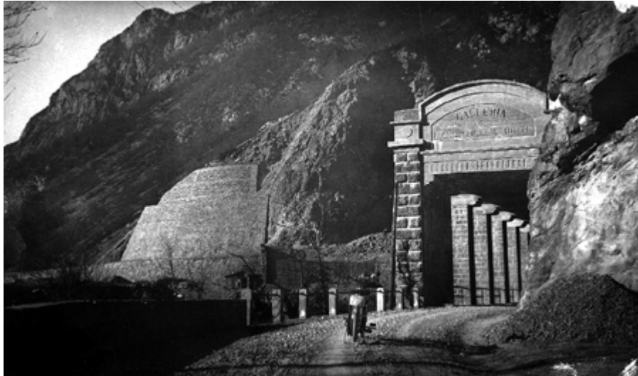
la galleria del Passo della Morte, Alta Valle Tagliamento.
